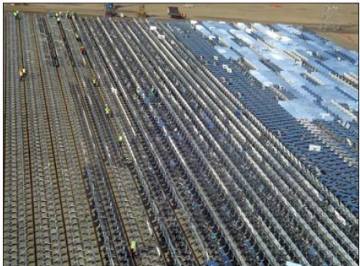
Espejos revestidos de plata mejoran la eficiencia de las instalaciones de Sierra SunTower de eSolar.
