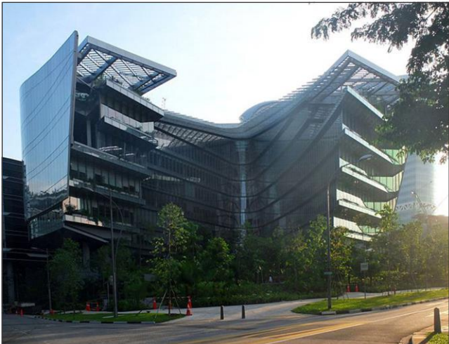
El edificio Sandcrawler de la productora Lucas Film en cuenta con cristal Solarban72 que contiene tres capas de plata.
